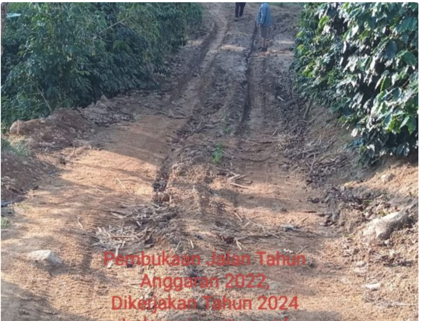
Proyek Pembukaan Jalan Tahun 2022, Dikerjakan Tahun 2024
